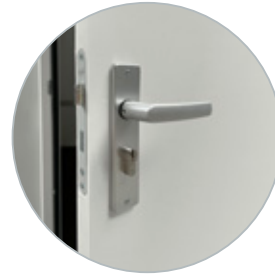
Rahmen und Eingangstür aus Holz
