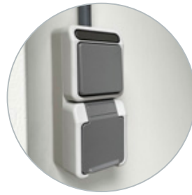
LED-Beleuchtung und Steckdosen
